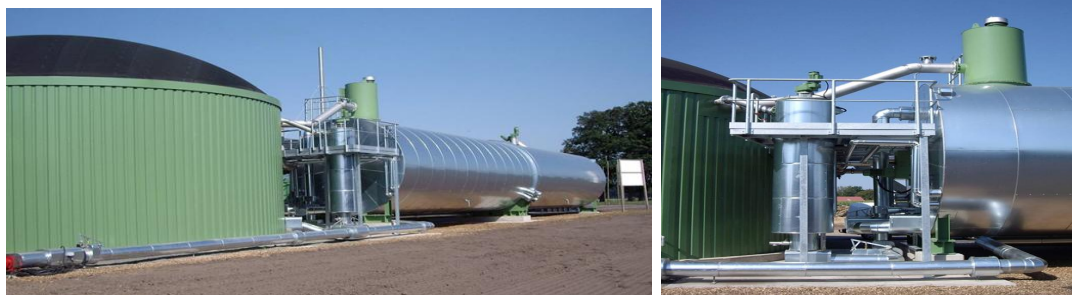
Фиг. 5 Инсталация за биогаз с непрекъснат процес
